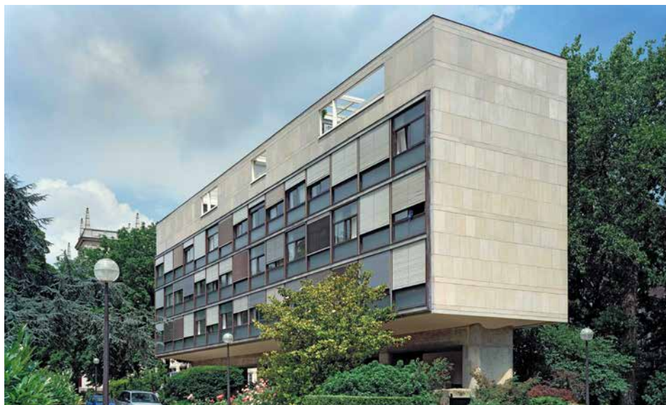
Bâtiment vu du côté sud
